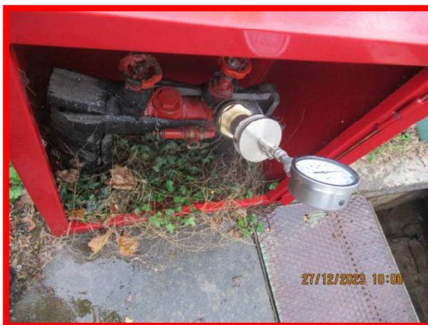
Al momento della prova, la pressione statica dell'acquedotto, rilevata tramite manometro installato sull'attacco VVF in linea era di circa **3,4 bar**.
