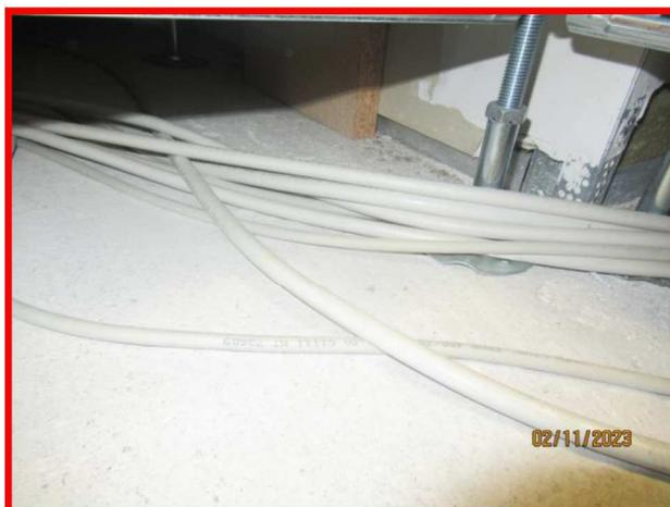
Nel progetto di riordino dell'impianto dovrà essere prevista l'estensione della protezione all'interno dello spazio nascosto sotto la pavimentazione galleggiante, con le relative spie visive di segnalazione in conformità ai requisiti normativi.
