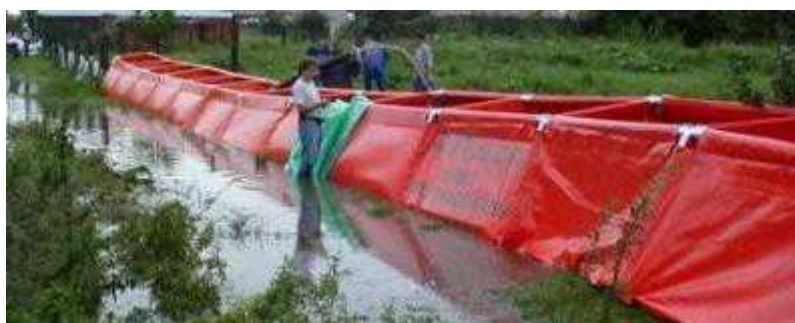
Figura 60 - Barriera temporanea antiesondazione riempita ad acqua
