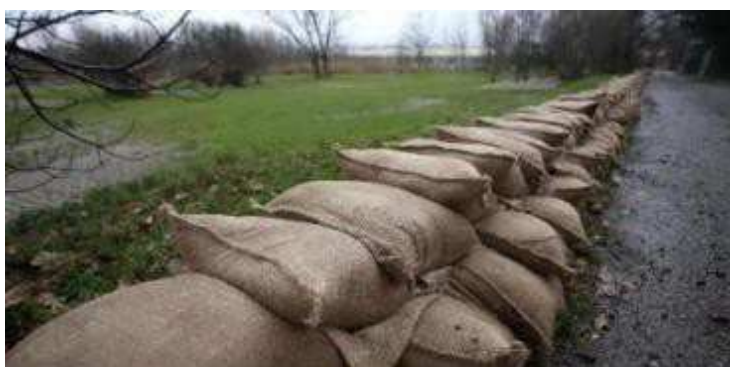
Figura 57 - Barriera temporanea antiesondazione in sacchi di sabbia
