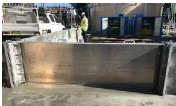
Figura 63 - Paratoia di chiusura a scorrimento orizzontale per un cancello a tenuta idraulica
