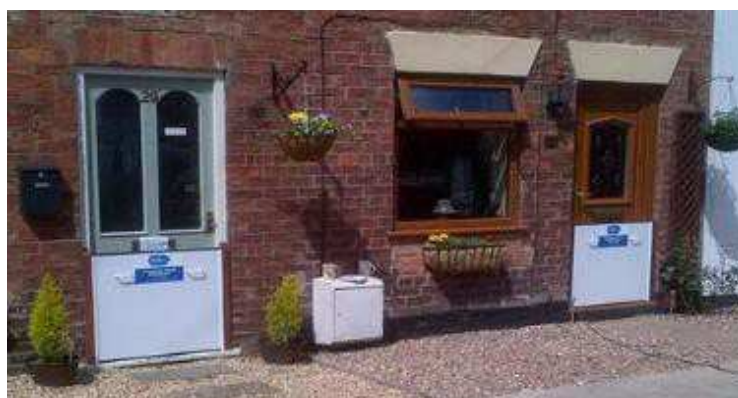
Figura 64 - Paratoie manuali a protezione di porte di ingresso
