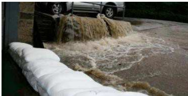
Figura 58 - Barriera temporanea in sacchi riempiti con materiale sintetico assorbente
