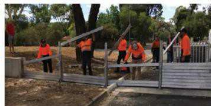
Figura 62 - Barriera temporanea modulare con pilastri e panconi manuali in alluminio
