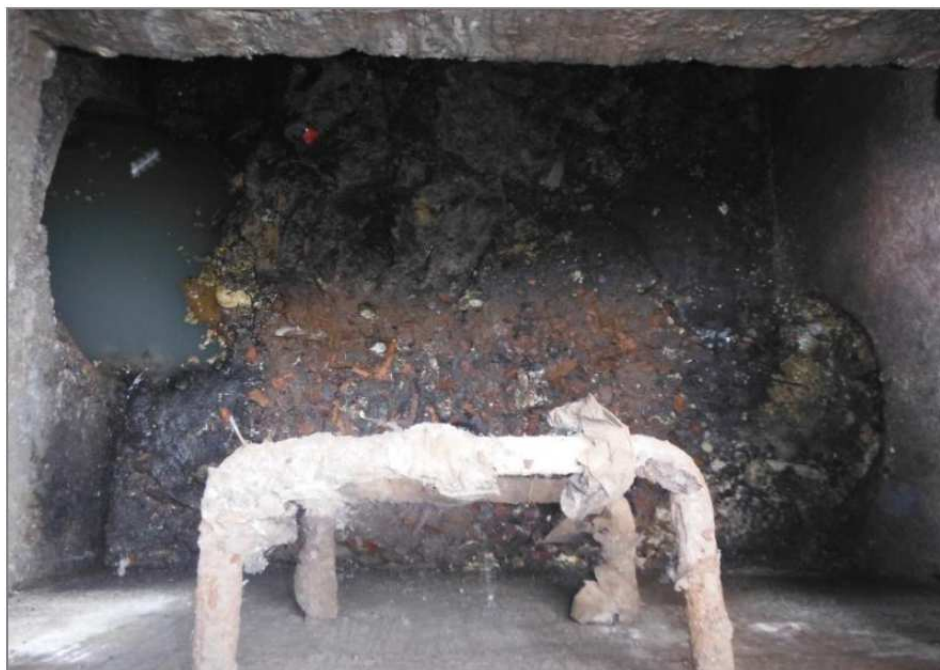
Figura 45 - Materiale depositato all'interno del pozzetto relativo al nodo 2420
