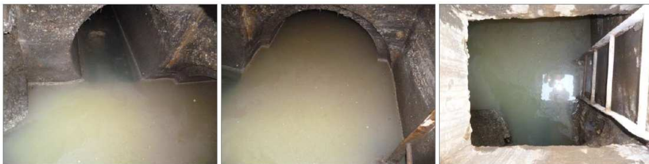
Figura 28- Partitore in corrispondenza del nodo 322 all'angolo tra le vie Gorizia e Briantea
