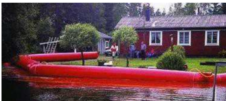
Figura 59 - Barriera temporanea antiesondazione riempita ad aria
