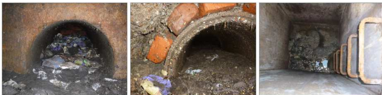
Figura 37- Materiale accumulato nei pozzetti 693, 398 e 395
